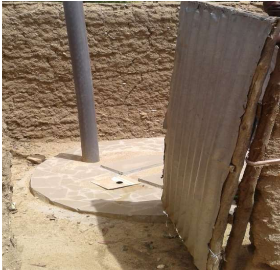
Pause tuyau de ventilation et construction de la superstructure
