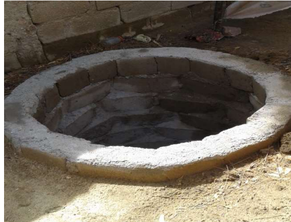
Stabilisation de la fosse
