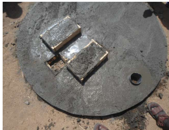
Coulage d'une dalle
